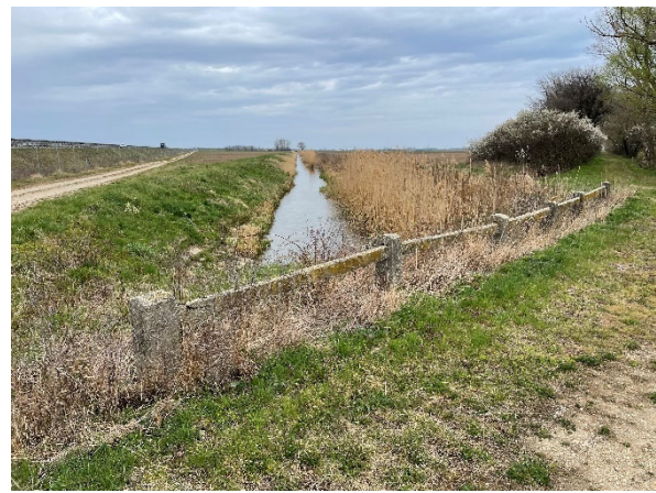
13. ábra: A Keszeg-ér északkelet felé nézve a dűlő úti vasbeton hídról (47+155 km)
