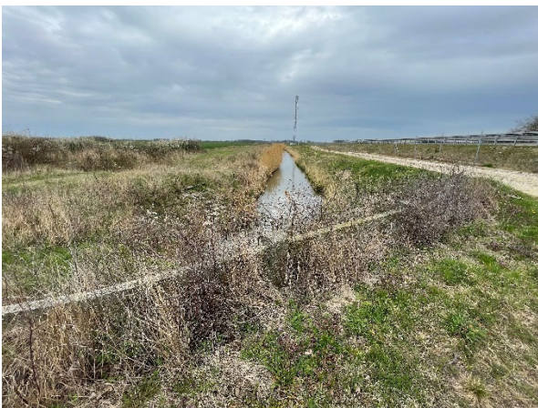
12. ábra: A Keszeg-ér délnyugat felé nézve a dűlő úti vasbeton hídról (47+155 km)
