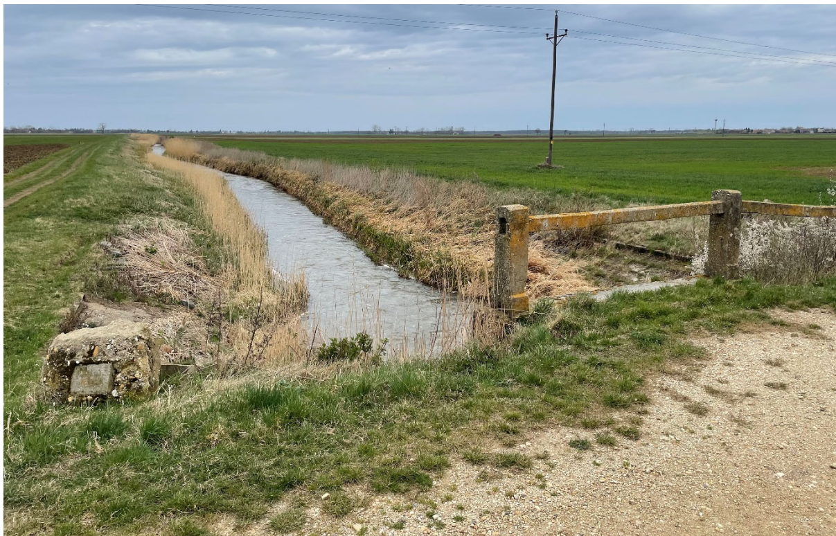
20. ábra: Dűlő úti vasbeton híd (45+237 km)
