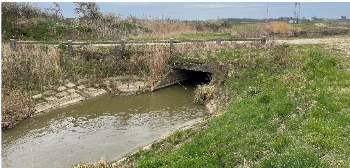
19. ábra: Dűlő úti vasbeton híd (47+155 km)
