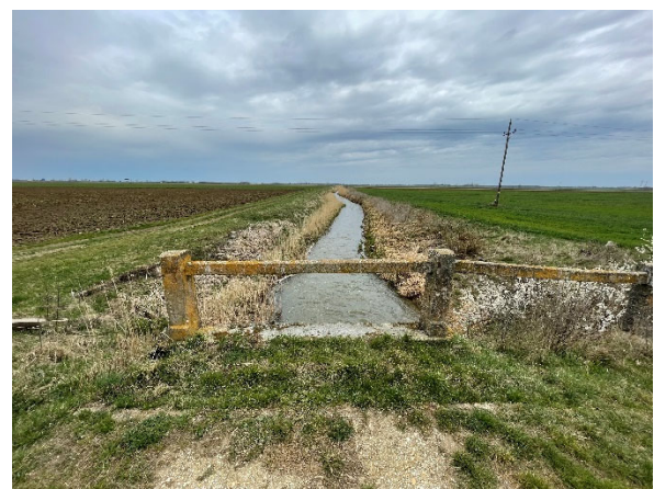
15. ábra: A Keszeg-ér északkelet felé nézve a dűlő úti vasbeton hídról (45+237 km)
