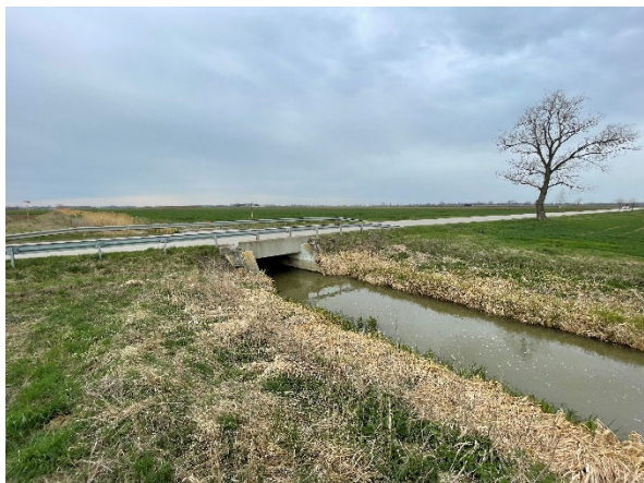
16. ábra: A Keszeg-ér a Rábakecölt az M86-os autópályával összekötő 8611 sz. út vasbeton hídja (délnyugat) felé nézve
