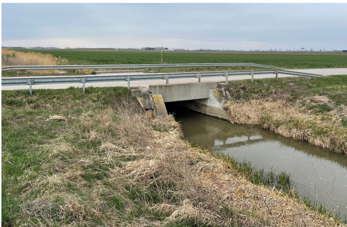
21. ábra: a Rábakecölt az M86-os autópályával összekötő 8611 sz. út vasbeton híd (44+330 km)
